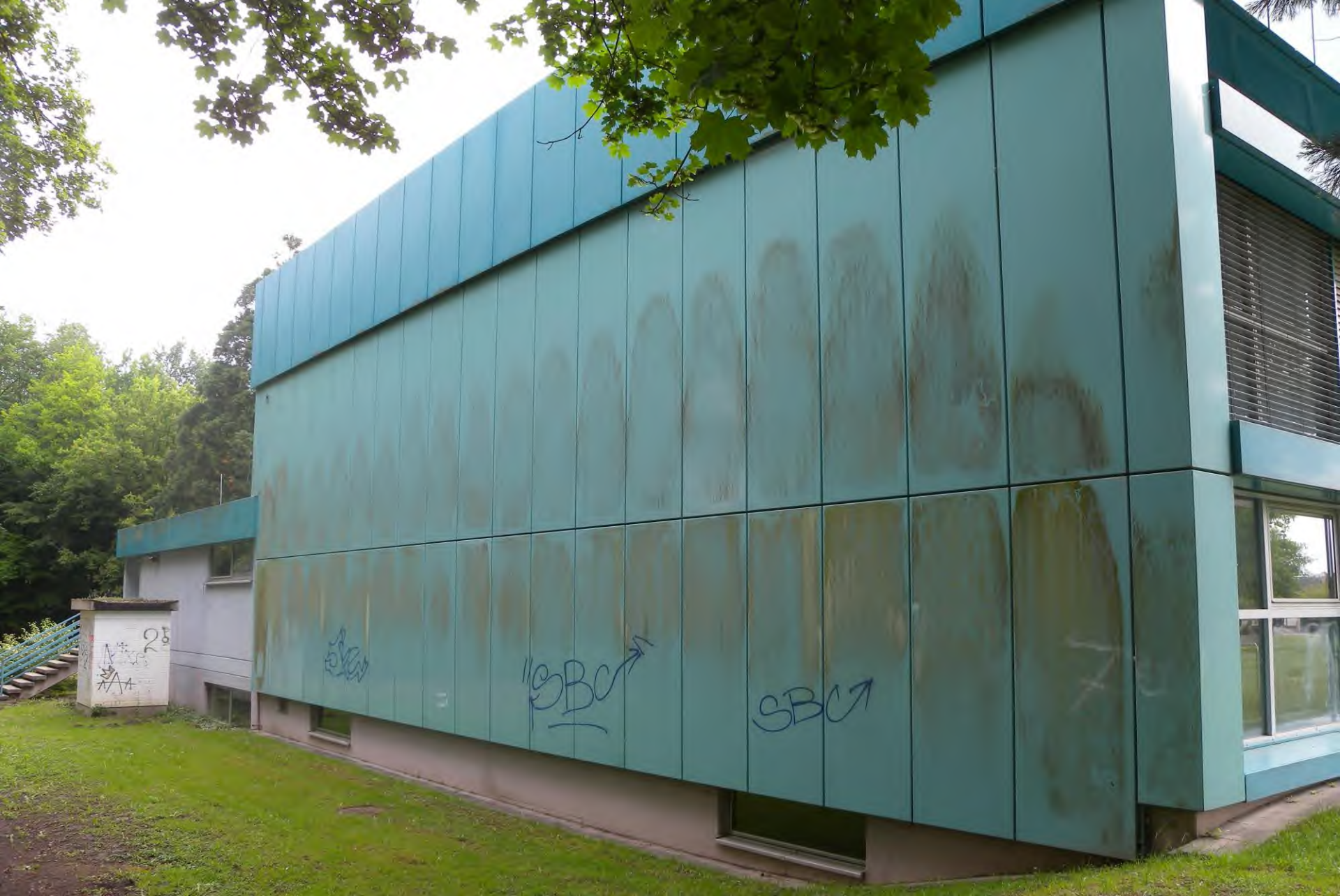
Hallenbad & Sporthalle Rheinmünster I Fassade
