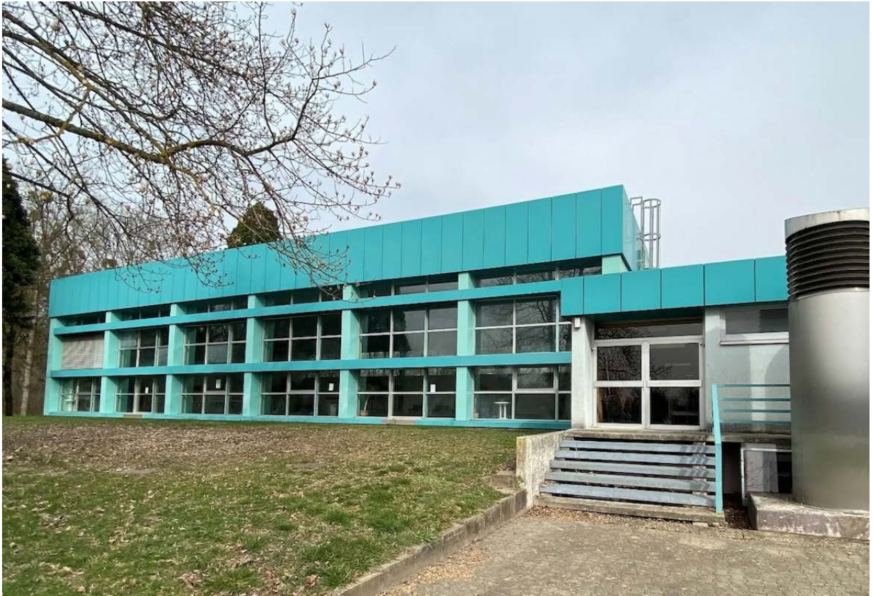
Abb.: Hallenbad (Südseite)
